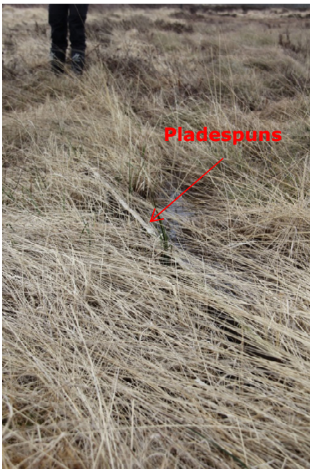
Figur 9. Pladespuns medfører højere vandstand.
