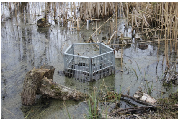
Figur 10. Kuppelrist i hovedafvandningskanalen øst for fugletårnet styrer vandspejlsniveauet.
