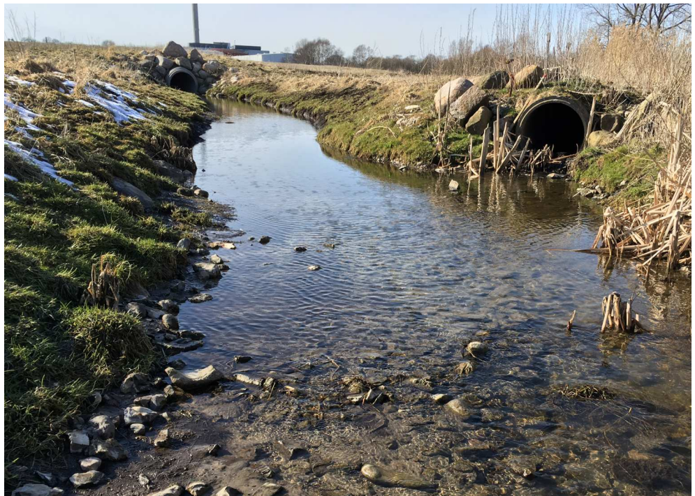
Figur 25. Det gamle udløb af en 800 mm rørledning fra Holmegaard Mose og ud i Svenskegrøften ses til højre i billedet, mens det nye afløb fra regnvandssystemet i Sibberup ses til venstre i baggrunden den 2. april 2018.
