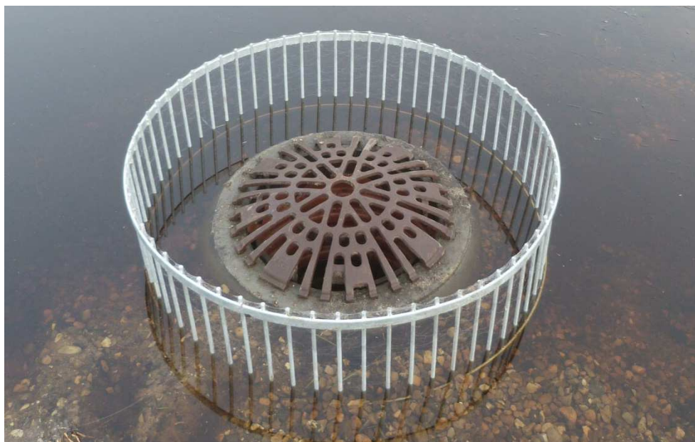
Figur 43. Eksempel på 600 mm overløbsbrønd med kuppelrist og et 1250 mm løvebur.
