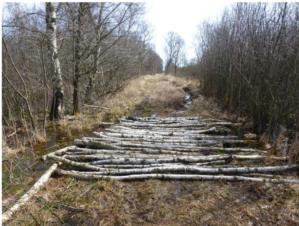
Figur 32. Forstærkning af Linje 20 Vejen med birkestammer udført på en strækning med gennemstrømmende vand set den 7. april 2018.
