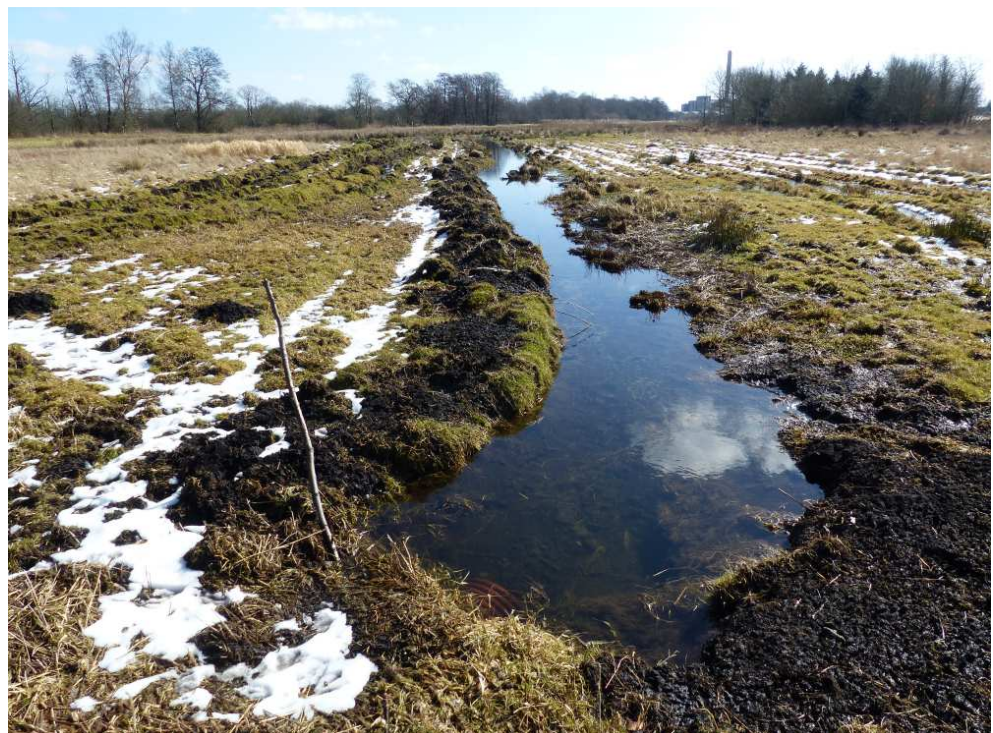
Figur 17. Grøften med indløbet til Glasværksengen fra grøfterne i Fensmark Skov set fra røroverkørslen den 2. april 2018.
