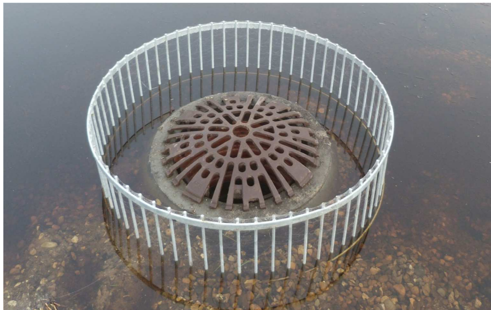
Figur 44. Eksempel på 600 mm overløbsbrønd med kuppelrist og et 1250 mm løvebur.
