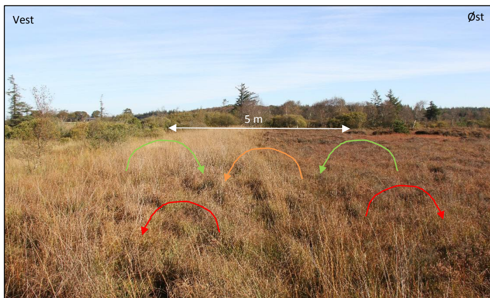
Figur 4: Principskitse for etablering af tørvedæmning (element nr. 4). Rød pil angiver afgravning, hvor græstørven lægges til side mod vest og øst. Orange pil angiver afgravning af tørv på det afrømmede østlige område og opfyldning af balken. Grøn pil angiver tilbagefyldning af græstørv og planering. Billedets retning er fra syd mod nord.
