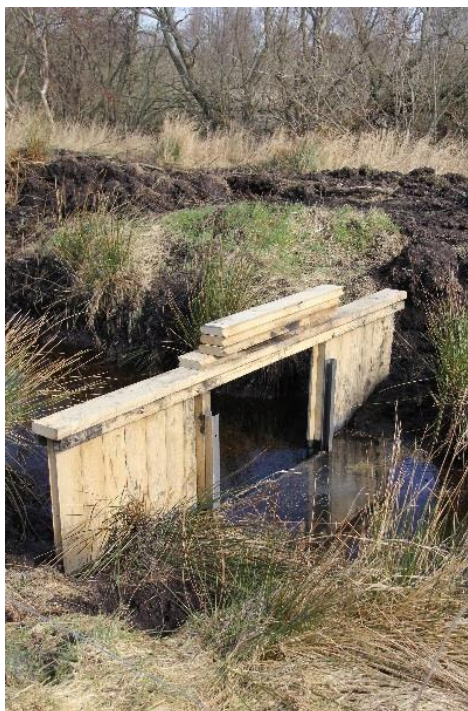
Figur 17: Simpelt træstemmeværk i den genoprettede højmoser i Sølsted Mose. Stemmebrædderne isættes metalslidsken på den lodrette kant af vandsluget til den ønskede overfaldskote.
