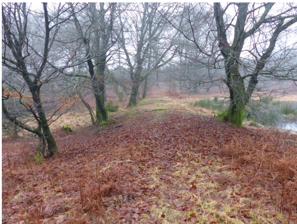
Figur 10. Dæmningen med vejsporet på tværs af Langemose set fra syd med søen til højre i januar 2018. Dæmningen ligger med krone i ca. kote 76,8 mDVR90.
